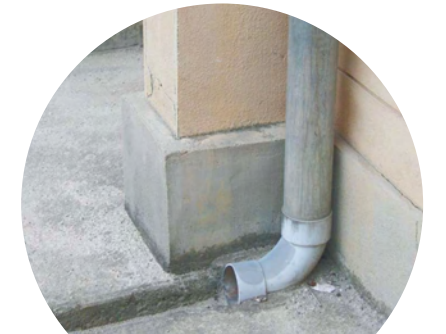
雨どい 水の流れ込むところには屋根に降った放射性物質が集まってきました。
