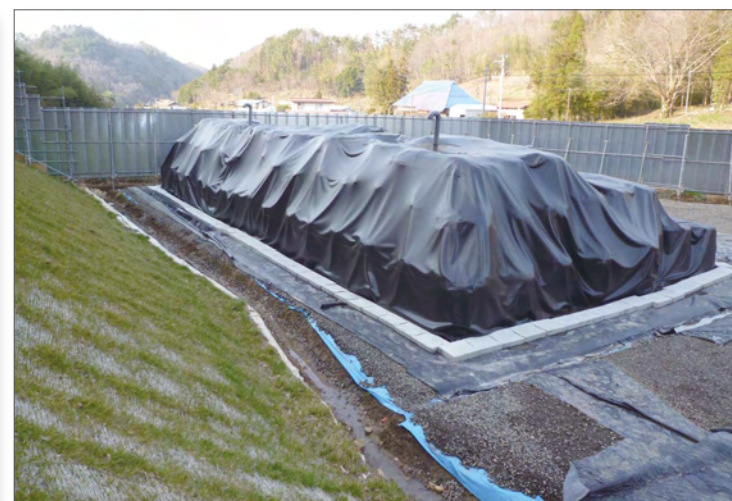
完成した仮置き場
